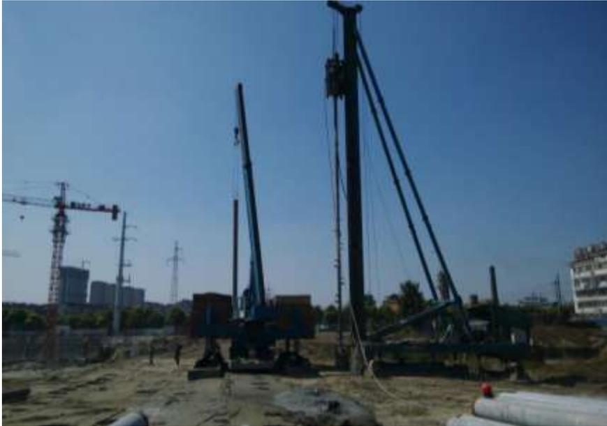
图 5 RCP 劲性复合桩施工场地，刚性桩采用静压法施工
