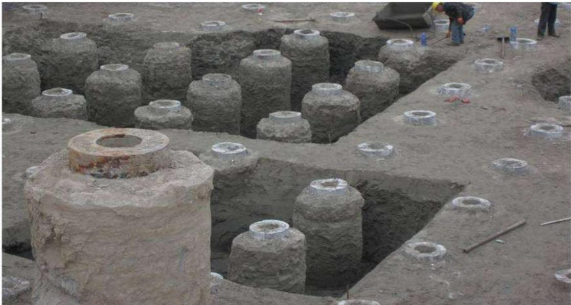
图 4 劲性桩复合实际效果
