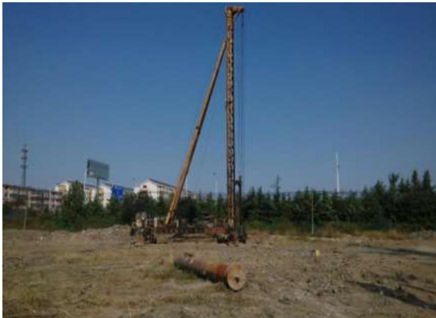
图 6 RCP 劲性复合桩施工场地，刚性桩采用锤击法施工
